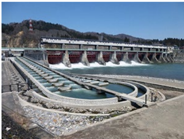
【魚道の整備（新潟県十日町市）】
