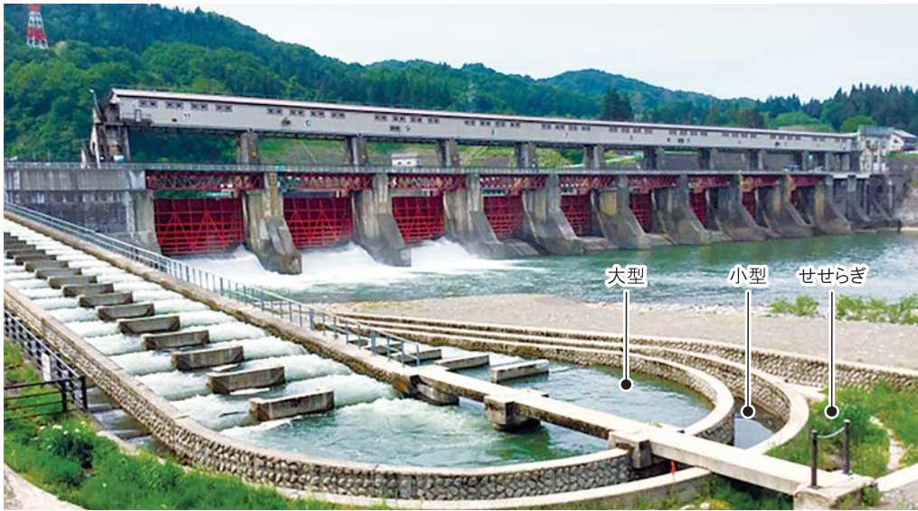
宮中取水ダムと大型、小型、せせらぎの3種類併設型の魚道
