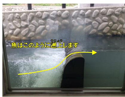
かんさつしつ こがたぎょどう ようす 観察室からみた小型魚道の様子
