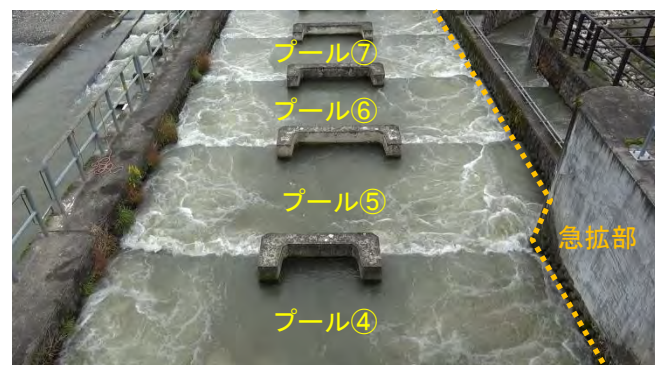
図 1.1.3 大型魚道の急拡部の状況（プール⑤）
