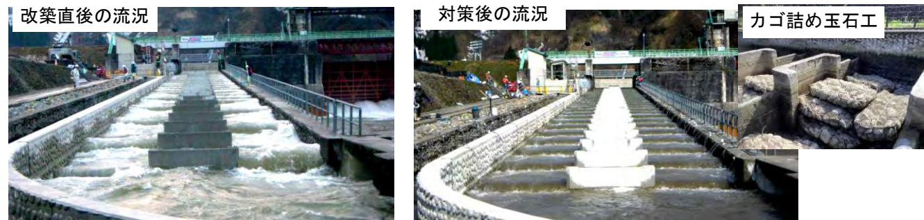
図 1.1.1 流況対策工の有無での流況（横波）の比較
