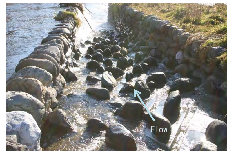
図 1.5.2 粗石付き斜路式魚道の事例（富士川支川の大武川(山梨県)）
