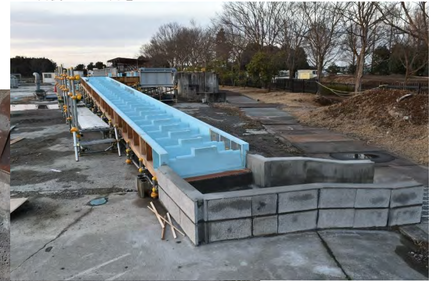
下流側より上流を望む
