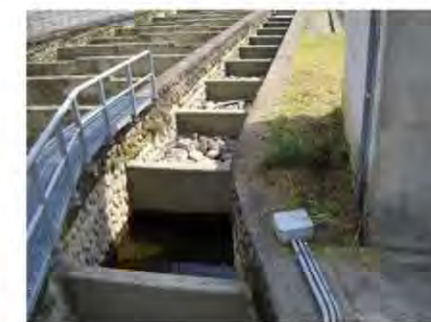
写真 2.2.8 現況の小型魚用魚道のピア部のカーブと投入した玉石
