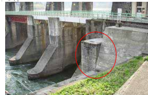
写真 排砂門扉塔全景
