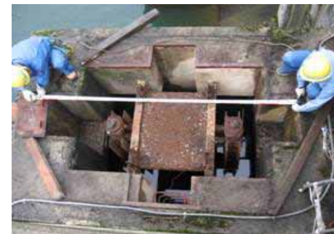
写真 排砂門扉塔開蓋状況
