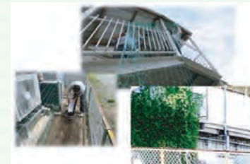
主な取組み箇所 平塚保線技術センター
