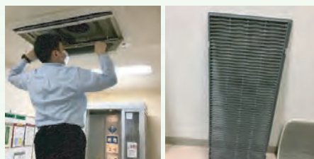
主な取組み箇所 館山駅
